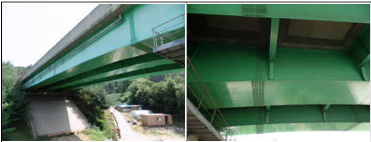
Steel Box Girder 외부 전경
